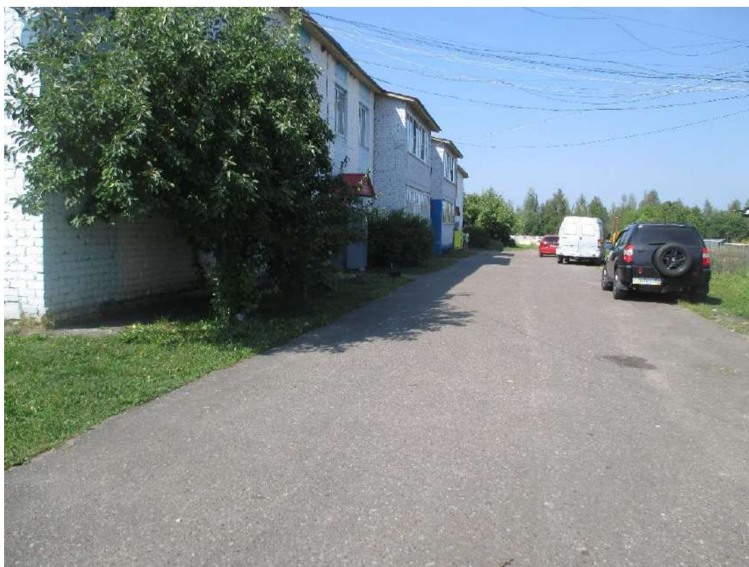
Общий вид дворовой территории (дворовый фасад дома №30)
