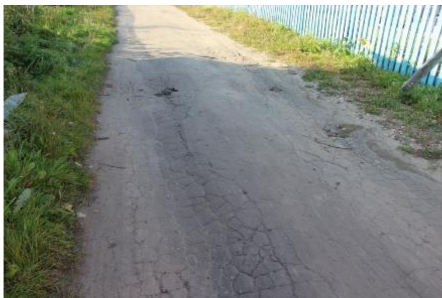
Дефекты асфальтобетонного покрытия проездов
