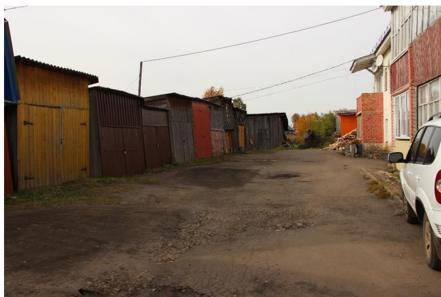
Дефекты асфальтобетонного покрытия проездов
